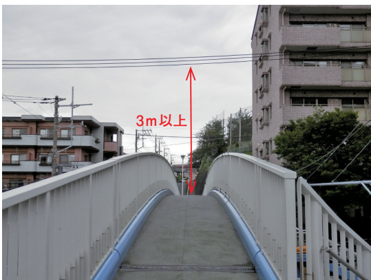
歩道橋上部の架空配線の例
