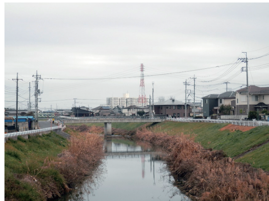
河川横断架空配線の例
