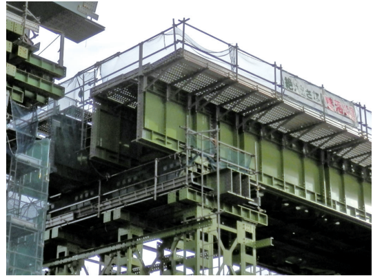
張り出し足場の例
